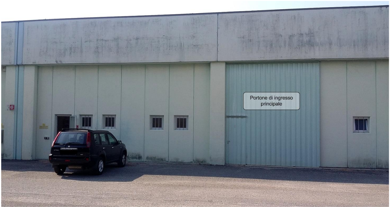
Figura 2. Vista della facciata esterna del Laboratorio, con dettaglio del portone principale.
